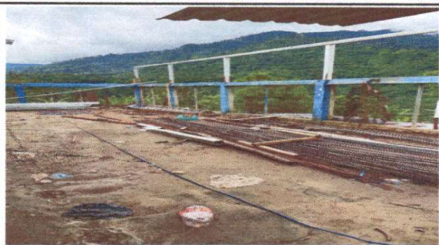
Foto 1: Sustitución de lámina por lámina troquelada aluzinc calibre 26 de patio, sustitución de capote de lámina para lámina troquelada
