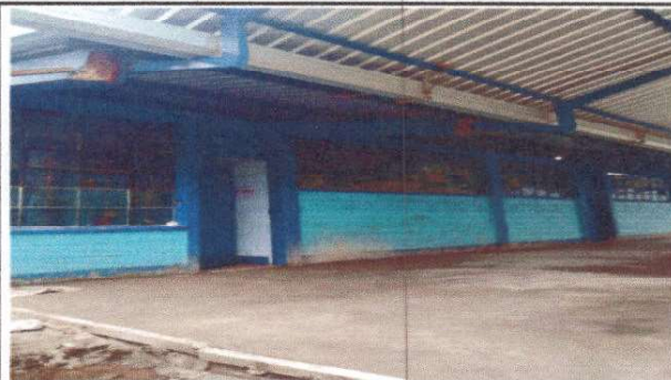
Foto 4: Reparación de piso de torta de concreto
