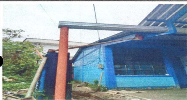
Foto 5: Sustitución de canal
