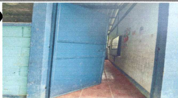
Foto 3: Mantenimiento a estructura de puertas (lijado, cepillado, sujeciones, aplicación de pintura)
